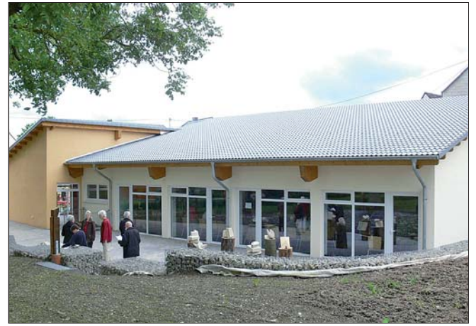
Das neue „Haus Propstei“ im Ortskern von Hambuch bildet seit seiner Fertigstellung den attraktiven Mittelpunkt der Gemeinde.
